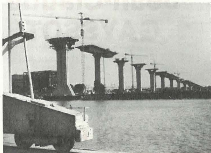
Le pont de Cheviré en construction.
